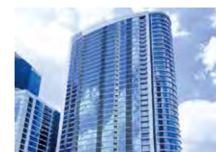
白石カルシウム(マレーシア)
